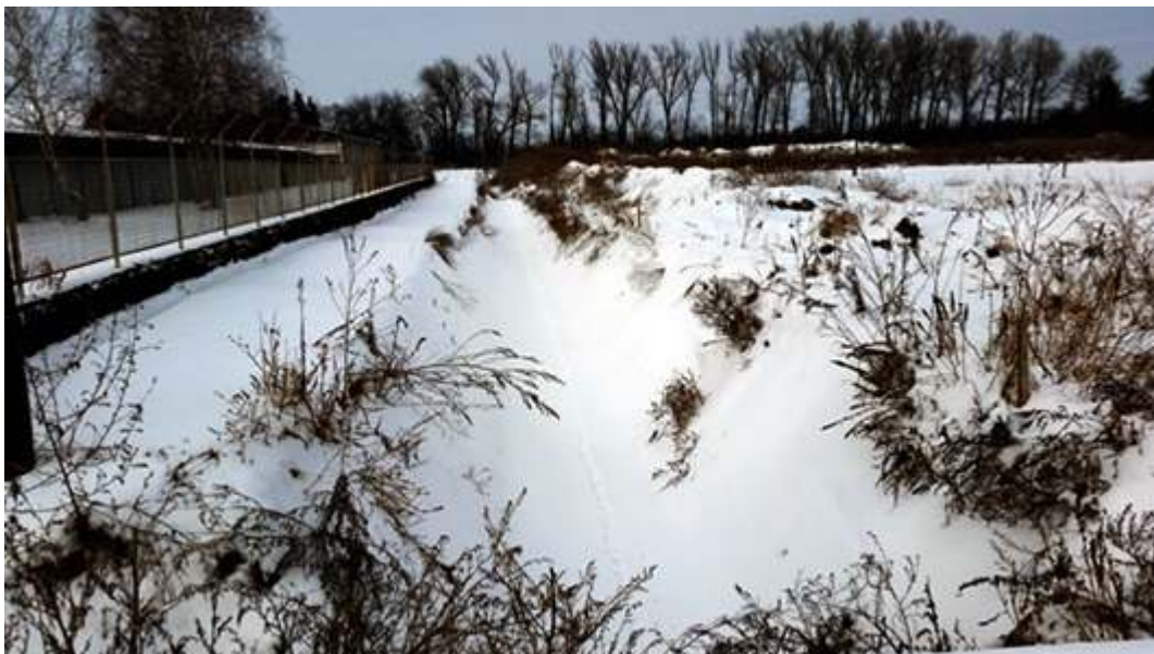
Slika 23. Kanal u koji će se ispuštati otpadne vode od pranja filtera
